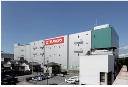
写真2 尼崎ディストリビューションセンター外観
