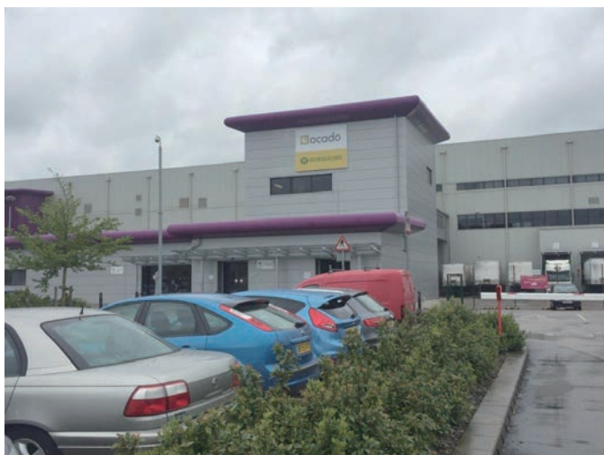
写真1 ドードンCFC(オカドとモリソンズの看板が掲げられている)
