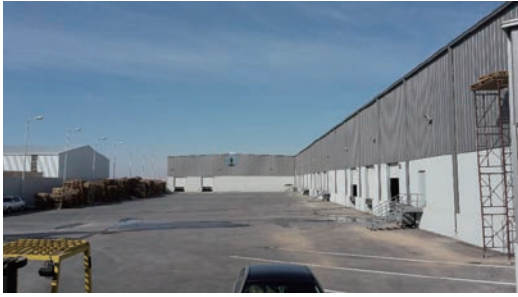
ザルカ物流倉庫
