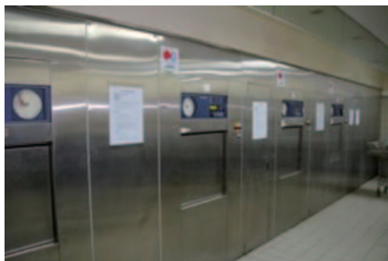
高圧蒸気滅菌器4台のうち3台が故障していた。ODA 援助でありながら、装置は欧州製である
