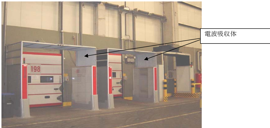
図表 3-21 ポータルの電磁波吸収体実施例
