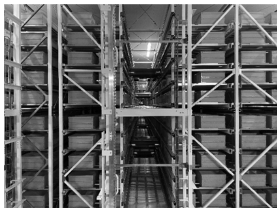
写真④ 自動倉庫
